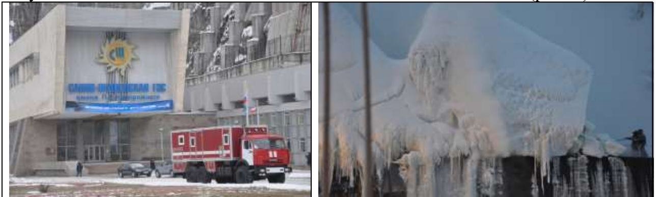
Рисунок 4 – Применение АПМ на Саяно-Шушенской ГЭС
