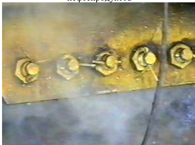
Рис.4. Узел крепления железнодорожной цистерны после очистки
