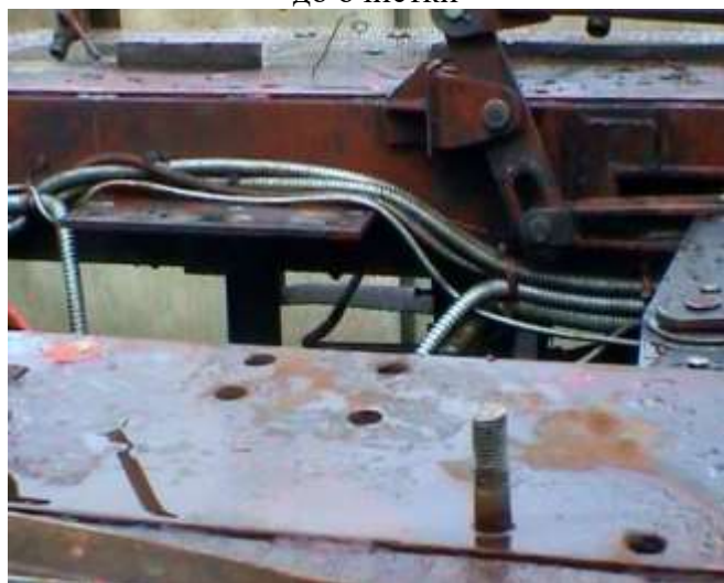
Рис. 8. Узел технологического оборудования после очистки струями ТАВ
