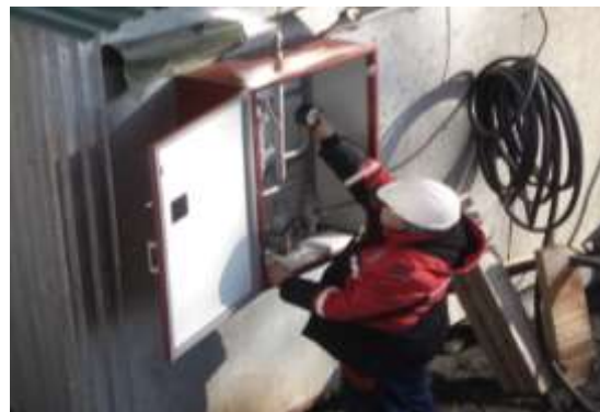
Рисунок 3. Шкаф подключения АПМ к системе подачи на высоту
