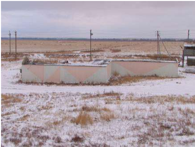
Рис 1. Макет кабельного коллектора: 2×3×30 м.
